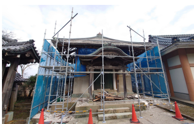
<除却前の経堂の様子>
